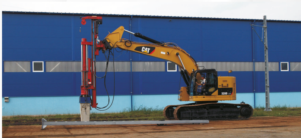
Nabíjanie pilót na železnici
