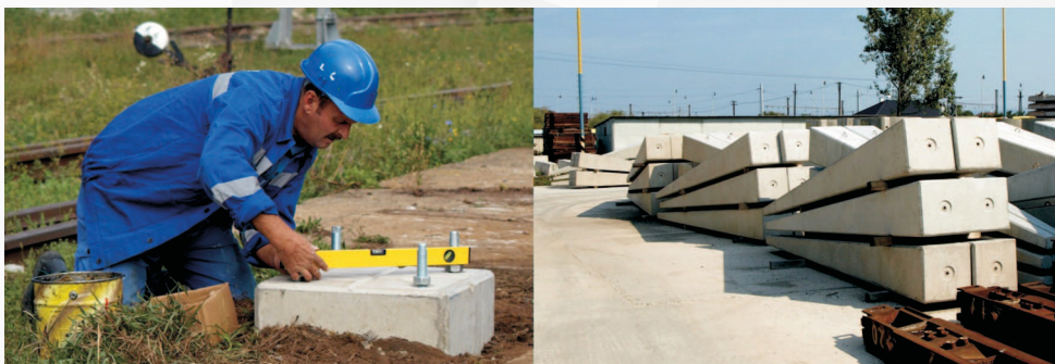
Osádzanie svorníkov, stavebné pilóty
